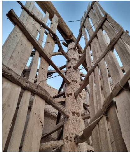
شکل ۷. ساختار سازه‌ای آسباد (نگارنده)
