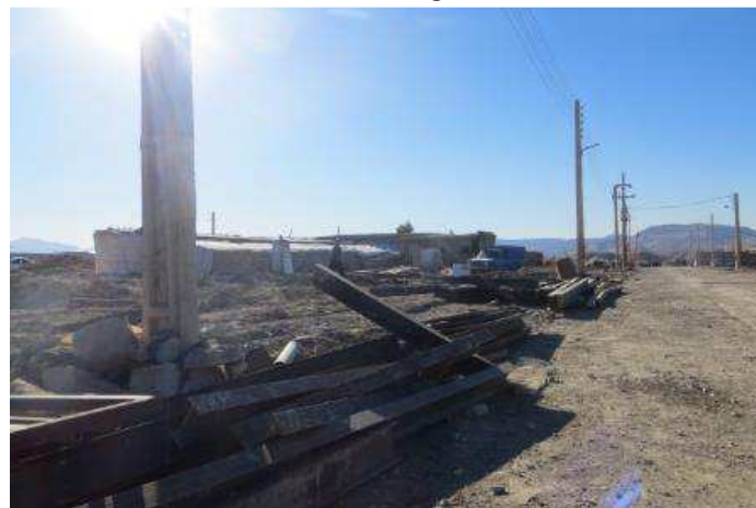
تصویر شماره ۵- بقایای تیر آهن‌های به جا مانده از اثر زلزله در مجاورت معبر اصلی روستای آبدالان هیرکی قابل مشاهده است. قبل از زلزله در مجاورت این معبر، خانه‌های مسکونی قرار داشته است.
