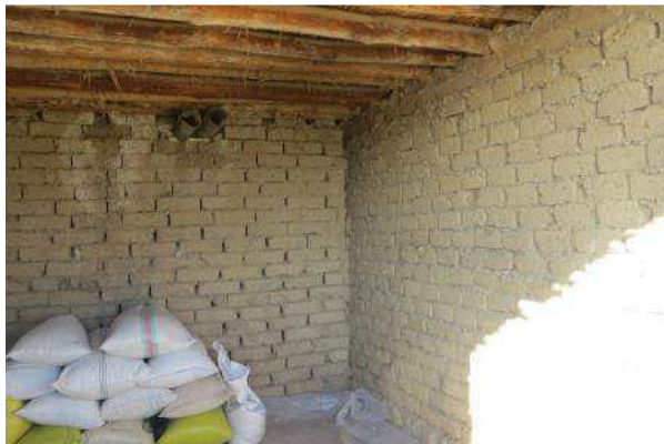
تصویر شماره ۸- نمونه دیگری از روش ساخت بومی؛ در این روش دارهای چوبی، از لبه‌های خارجی دیوارها ۲۰ سانتی متر بلندتر اجرا می‌گردند، تا در جابجایی‌های زلزله مقاومت مناسبی نشان دهند، و البته موفق بوده‌اند.
